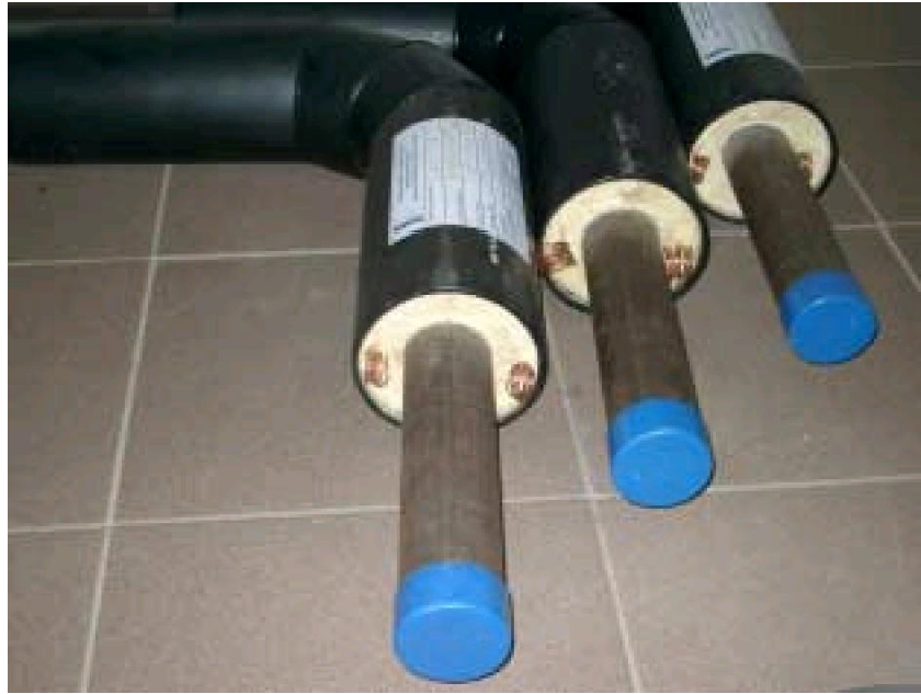
4 pav. Laidų montažas alkūnėse
